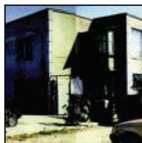
înainte de reabilitare
